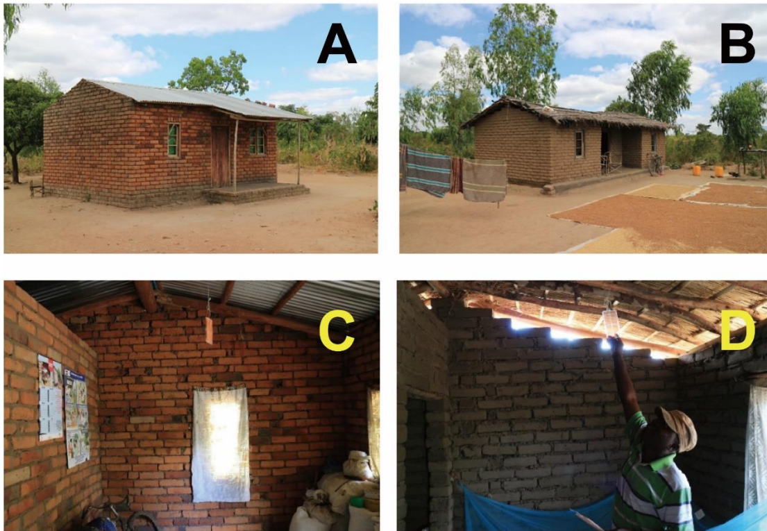
図3 マラウイ Zomba 地区の典型的家屋. A:トタン屋根を有する焼成レンガ作りの家屋, B:茅葺き屋根を有する日干しレンガ作りの家屋, C:トタン屋根の家屋の多くはeaves構造を持たない, D:茅葺き屋根の家屋の多くはeaves構造を有する.
