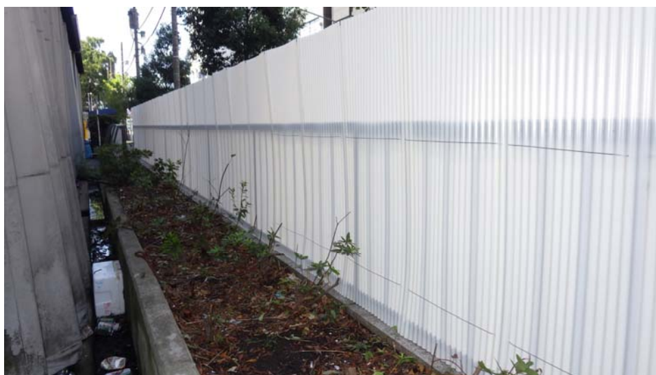
ネズミの移動阻止に利用したフェンス
